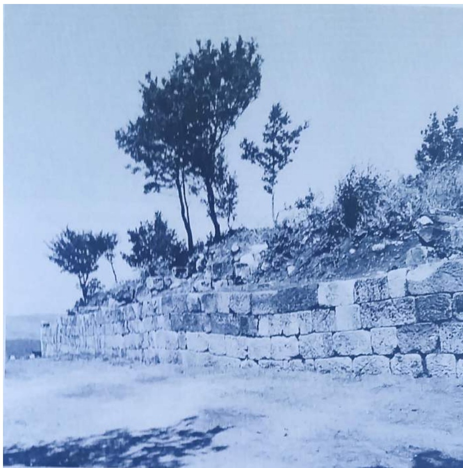
Fig.4: Pietragalla. Loc. Monte Torretta. Tratto del muro di cinta
